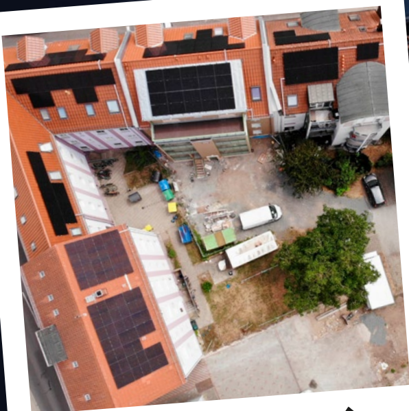
Unser energieautarkes Haus „NATURA“ in der Feldstraße 6 in Delitzsch
